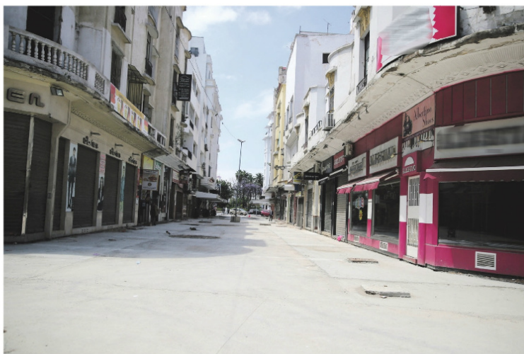
Les rues sont désertes au centre-ville. Ce qui devrait faciliter la tâche des ouvriers sur le chantier de mise à niveau de la rue piétonne prince My Abdellah (Ph. Jarfi)
